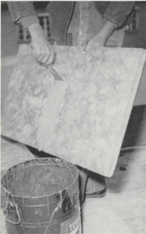
205 Wärmedämmung des massiven Rohbaues mit kunstharzgebundenen Mineralfaserplatten vor der Natursteinversetzung des Hochhauses Abb. 204
